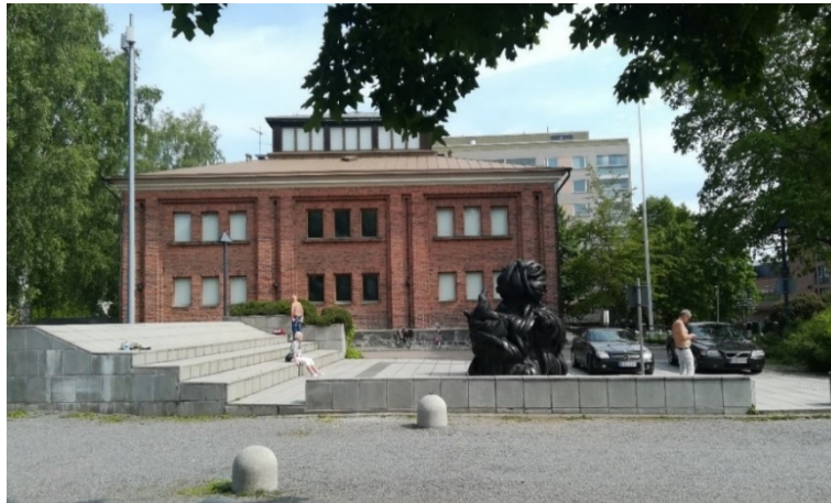
Kuva 9: Tampereen taidemuseo vihittiin käyttöön vuonna 1931. Museota peruskorjattiin ja laajennettiin maanalle vuonna 1983. Samassa yhteydessä pihalle rakennettiin terassiauditorio, jonka katsomorakenteen kautta avattiin ikkunoita maanalaisiin tiloihin.
